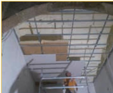
arco interior. Así se consigue una aireación natural de la cámara que permita que no haya cambios bruscos de temperatura y por lo tanto que evite la condensación.
